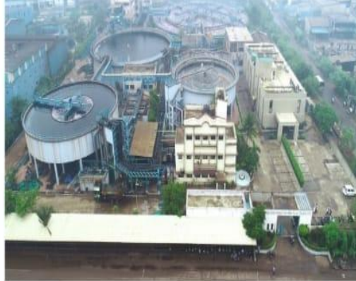
GESCSSL CETP PLANT
